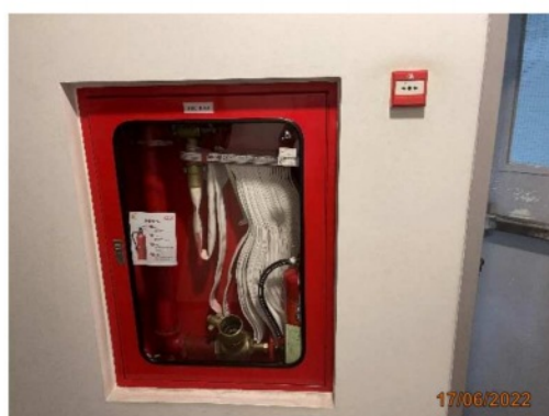
รูปที่ 2-28 ตู้เก็บสายฉีดน้ำดับเพลิงพร้อมอุปกรณ์
