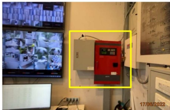
รูปที่ 2-29 แผงควบคุม (Fire Alarm Control Panel : FCP)
