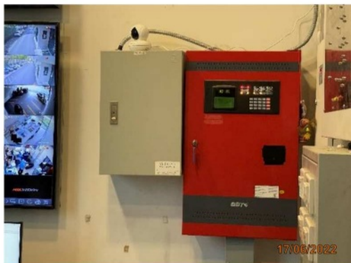
รูปที่ 2-29 แผงควบคุม (Fire Alarm Control Panel : FCP)
