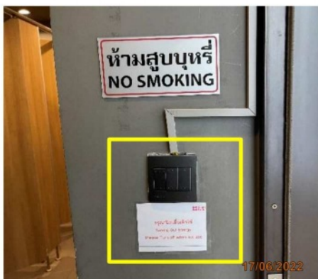
รูปที่ 2-25 แยกสวิตช์ควบคุมอุปกรณ์ไฟฟ้า
